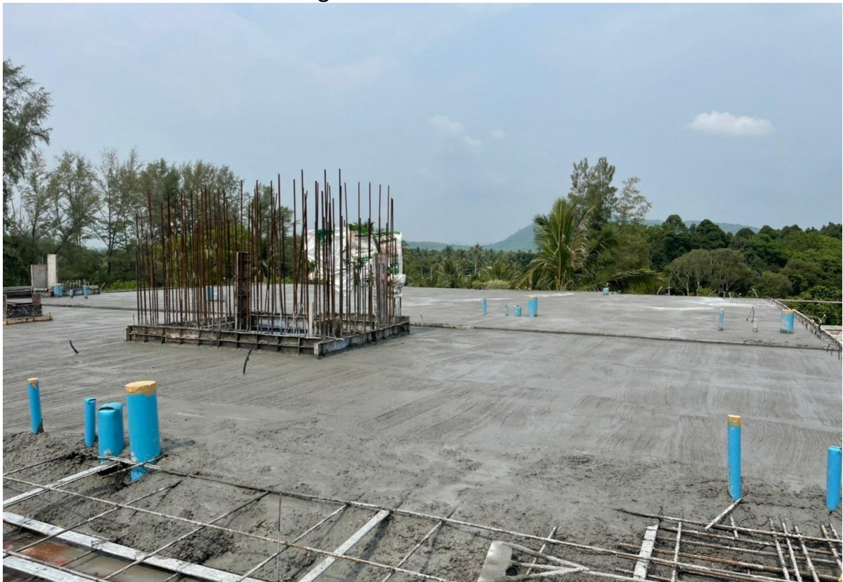
Cement Pour Roof Sab building 2
