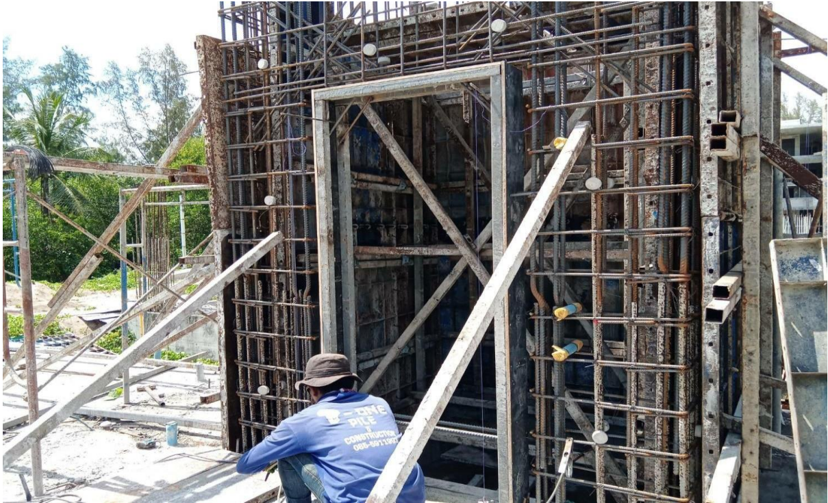
Lift Core steelwork 3G-31 ready for shuttering pre pour
