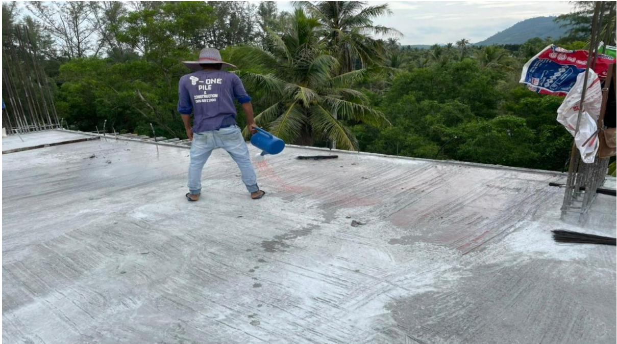
Slab 2-2 Post pour Inspection/treatment
