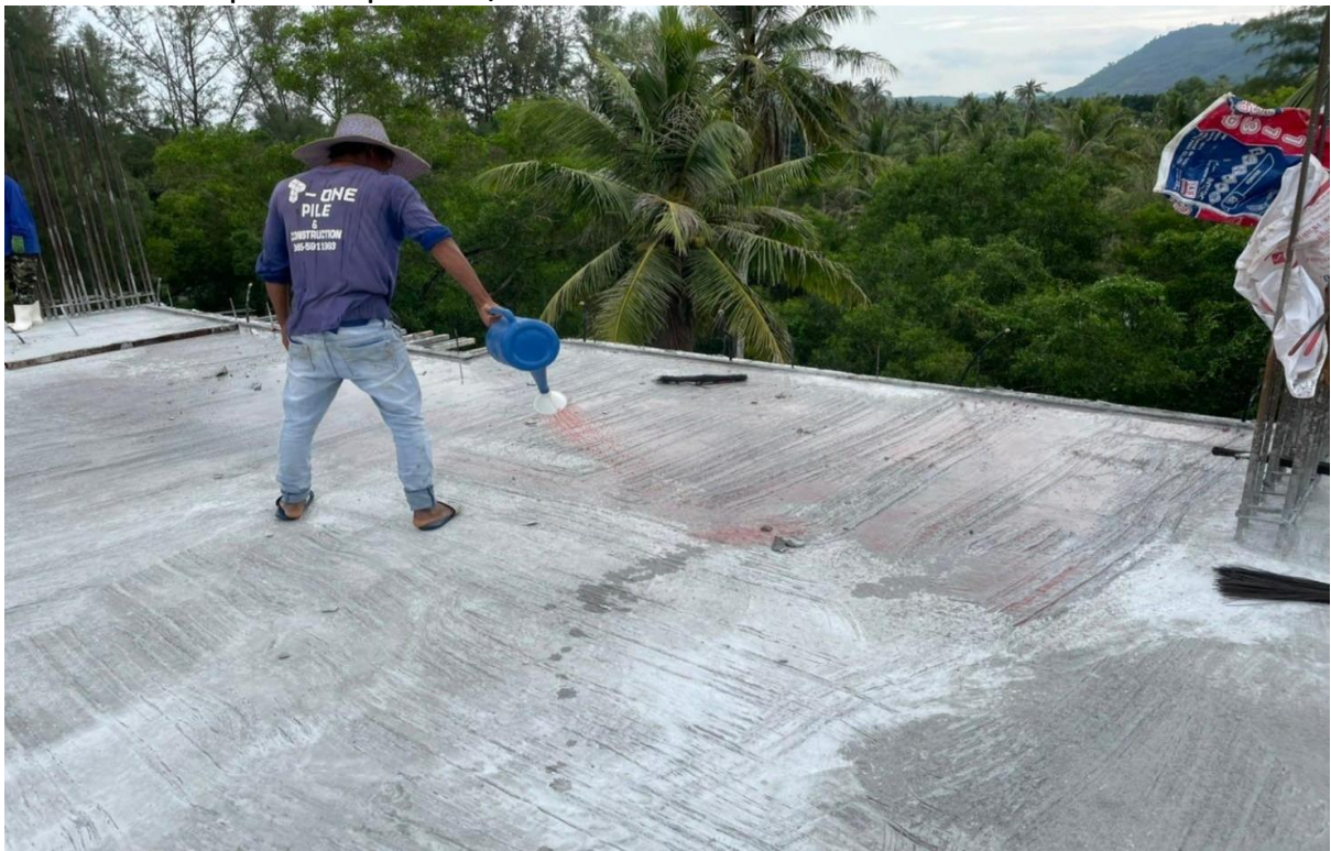
Slab 2-2 Post pour Inspection/treatment
