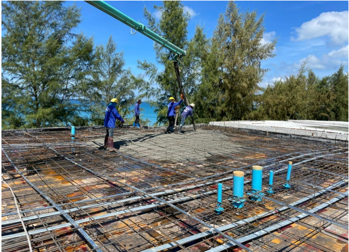
Pouring Slab 8 Roof
