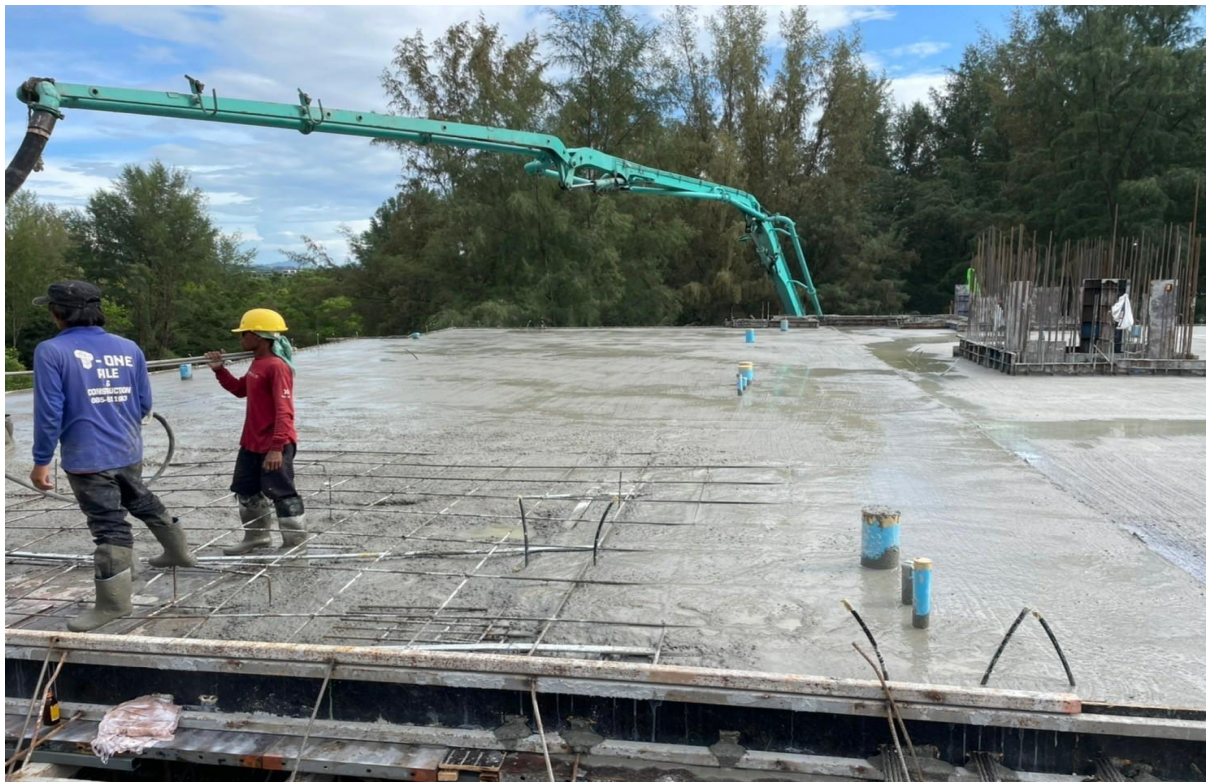
Pouring slab 8 Roof
