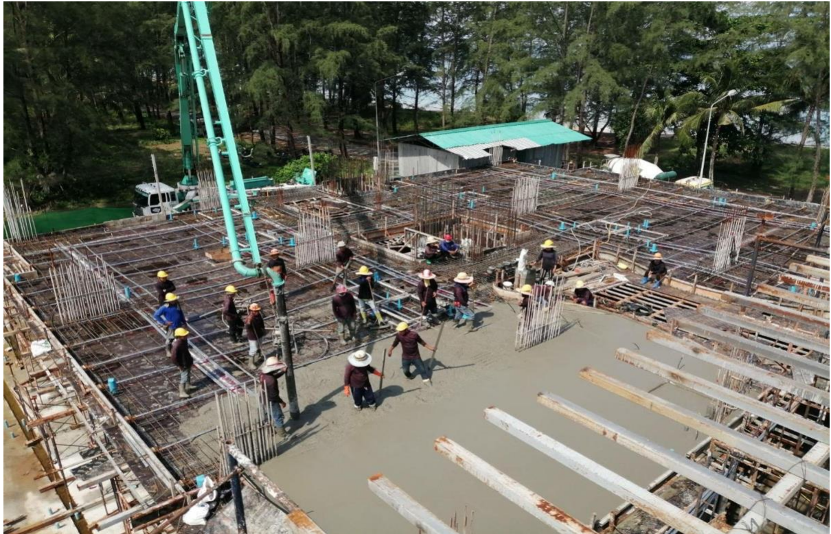
Pouring Concrete Slab 8-1
